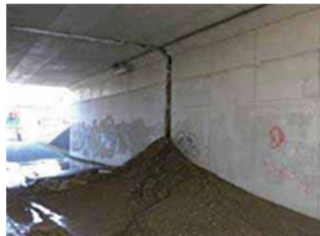
図 1.1.1 継手の開きから流入する土砂 (2011年東北地方太平洋沖地震による被害事例)
