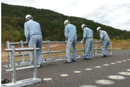
センターパイプ(部材取外し後)
