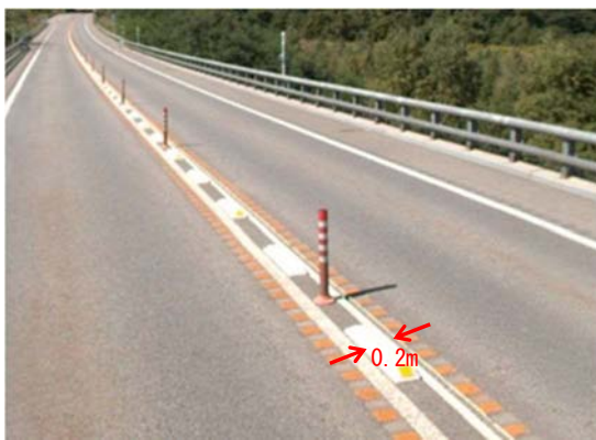
長大橋梁・トンネル区間の現況〔ラバーポール〕
