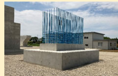
▼ 橋脚配筋模型
