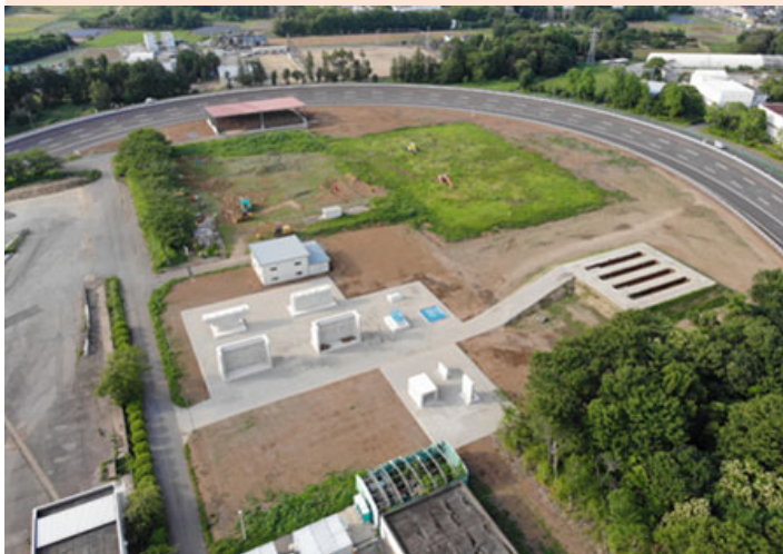
▲建設DX実験フィールド全景
