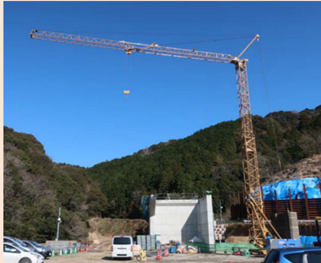
▲定置式水平ジブクレーン（設置例）
