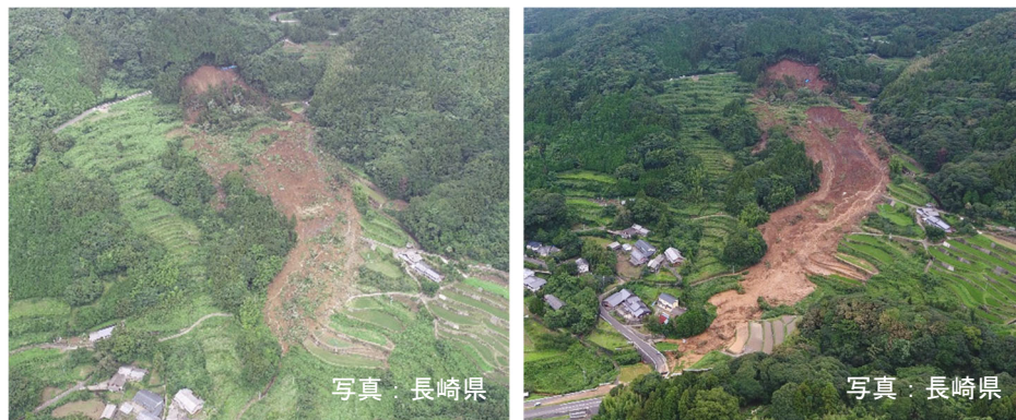
参図 1 地すべり発生後の空中写真（左：令和 2 年 7 月 11 日、右：令和 2 年 7 月 24 日）
